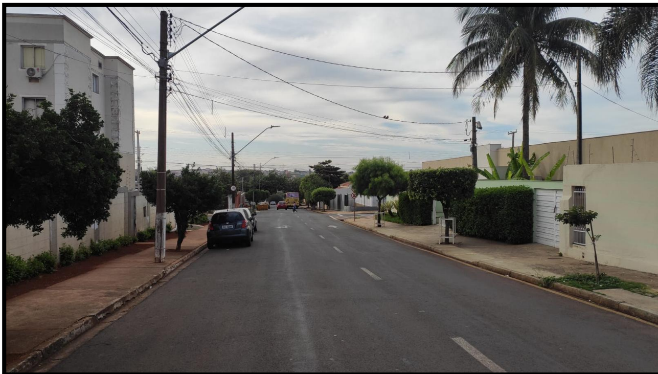
Vista do local – Sentido Sul / Norte
