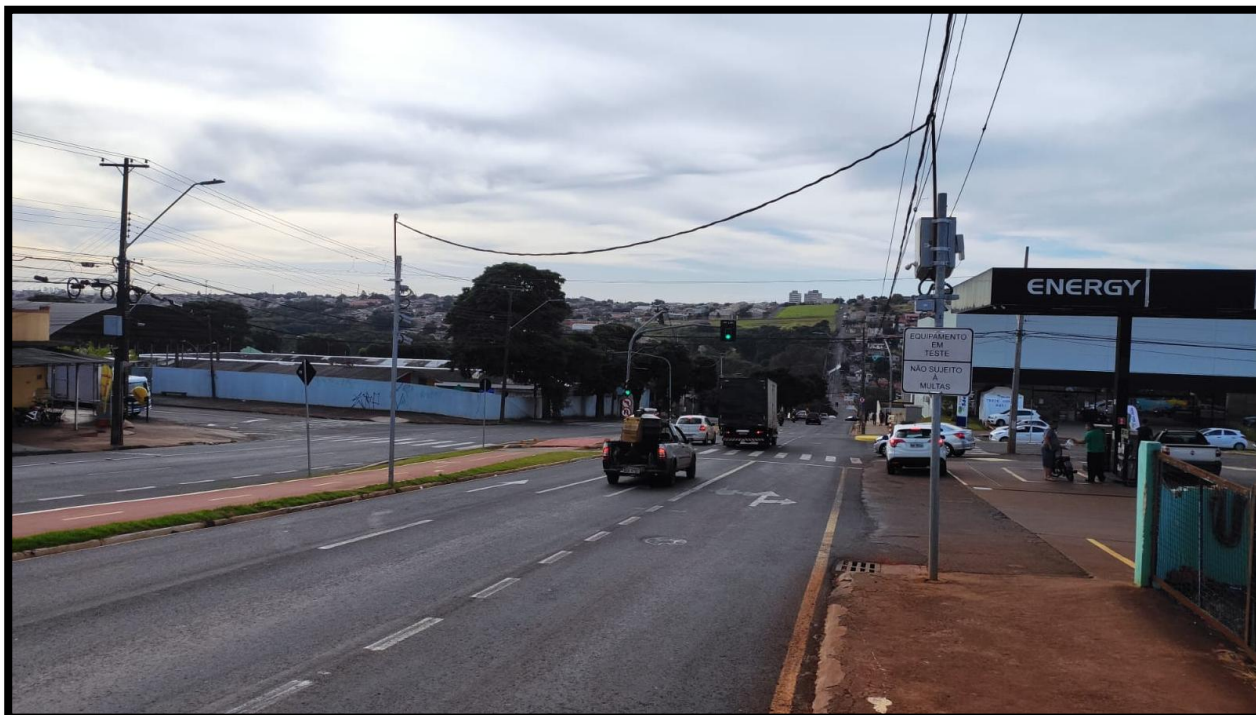
Vista do local – Sentido Sul / Norte
